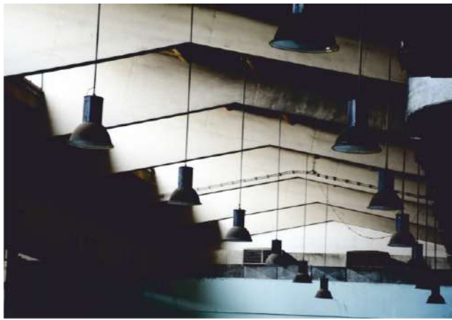
Resim 10: MKE Pil Fabrikası Yönetici Lojmanı ve üretim yapısı betonarme makas sistemi. Fotoğraf: Veyisi SAĞLAM.
