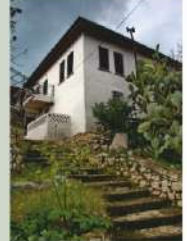
Yapının onarım öncesi hal, güneydoğu cephesi
