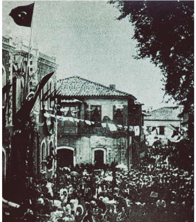
Resim 2: Eski Belediye Binası
